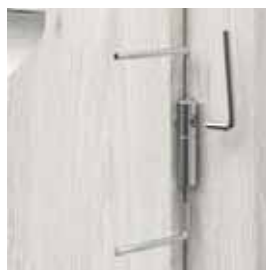
регуловка регулируемых полушарнирных петель 3D
