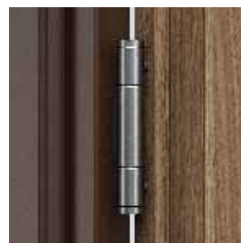
усиленная трехэлементная петля
